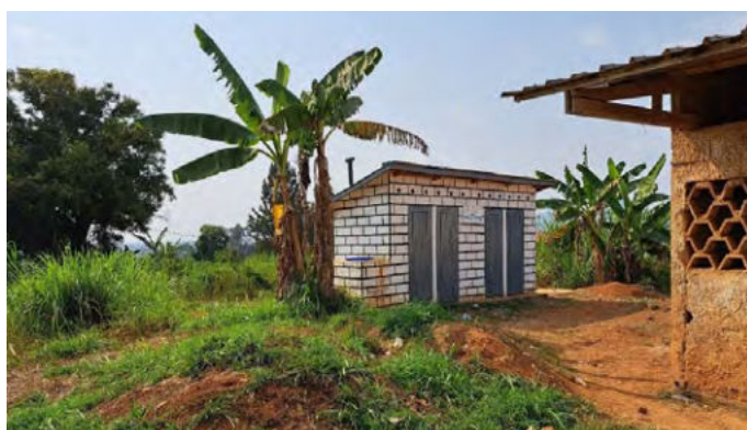
Mbankomo au Cameroun. Construction de quatre latrines écologiques pilotes dans deux écoles. ©UNICEF
